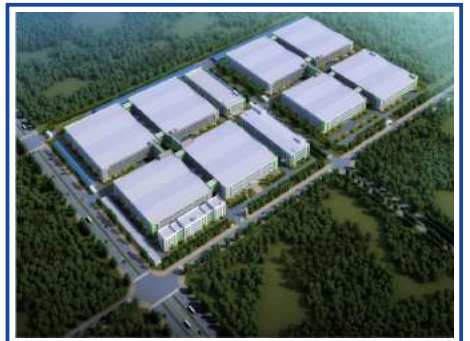
NHÀ MÁY GOERTEK - BẮC NINH
