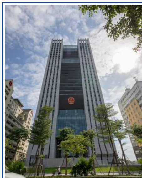
TÒA NHÀ VIỆN KIỂM SÁT NHÂN DÂN TỐI CAO
