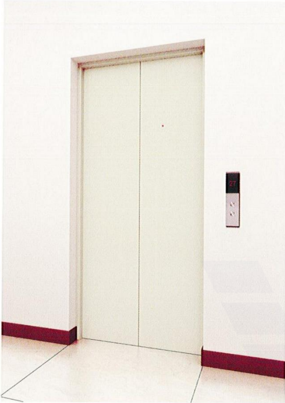
Nút gọi tầng: ZPIA09-G110 Vật liệu cửa tầng: thép mạ Vật liệu khung bao che: thép sơn mạ
